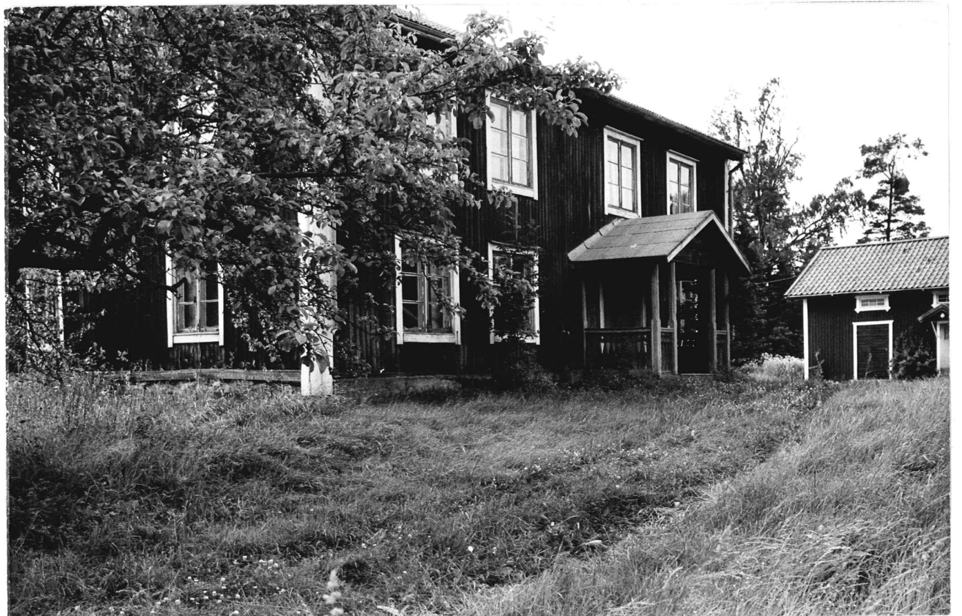
Gamla manbyggnaden, O-fasaden
