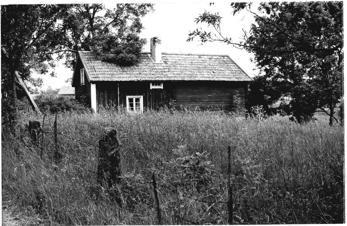
Tvättstuga och bod
